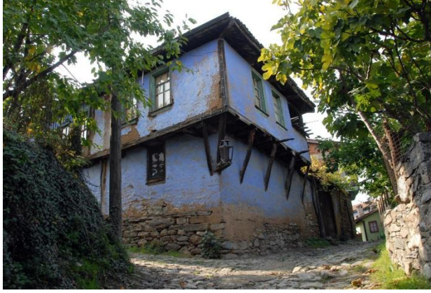
Fotoğraf 15. Cumalıkızık Köyü'ndeki Sivil Mimarlık Örneği
